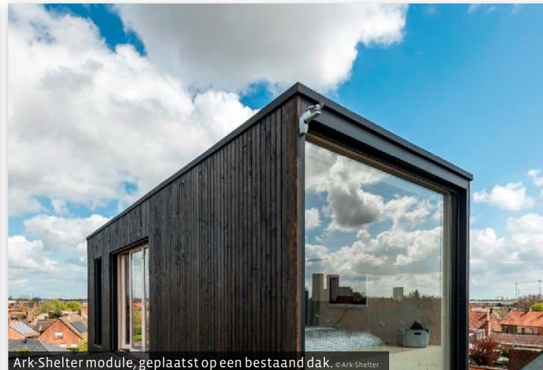
Ark-Shelter module, geplaatst op een bestaand dak. © Ark-Shelter
