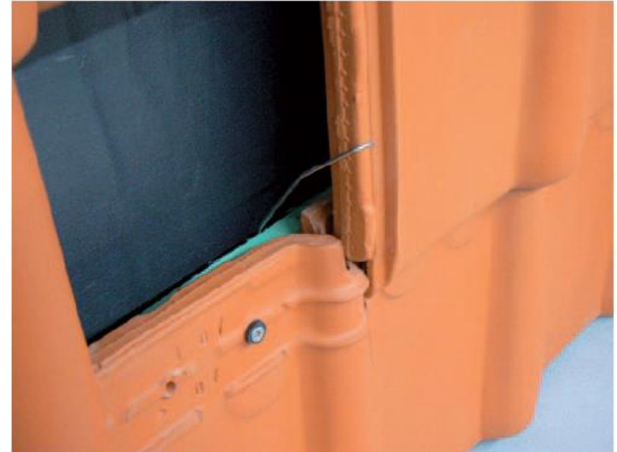
Afb. 1 Voorbeeld van de bevestiging met een haak en een schroef.
