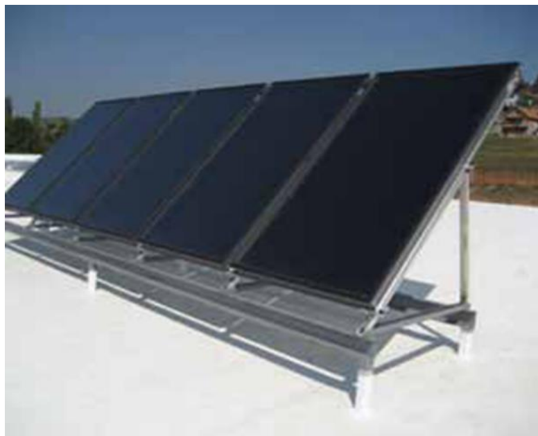
Door het dak bevestigd
