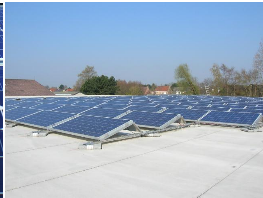
Los op het dak, met ballast
