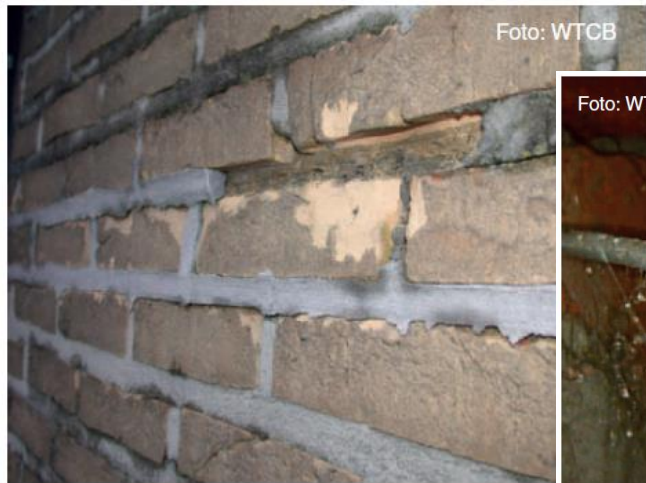
Afb. 8 Vorstschade aan de stelmortel (gele kleur) en uitstoten van de voegen.
