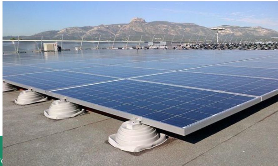
Een nieuw plat dak voor vele jaren
