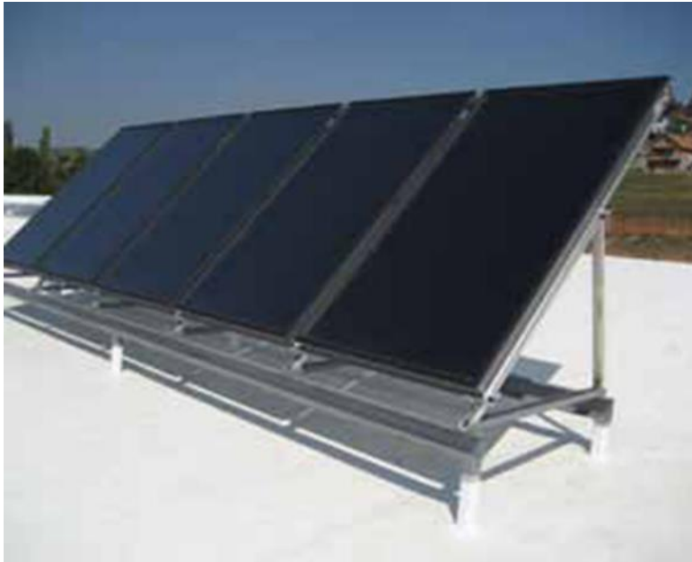
Door het dak bevestigd
