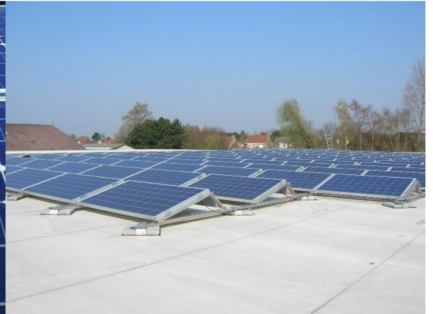
Los op het dak, met ballast
