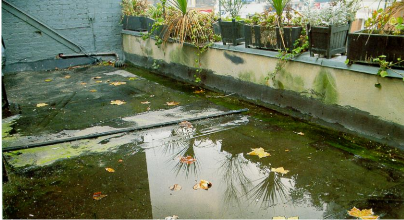
Afb. 27 Nominale helling van het dakvlak en van de dakgoten.
