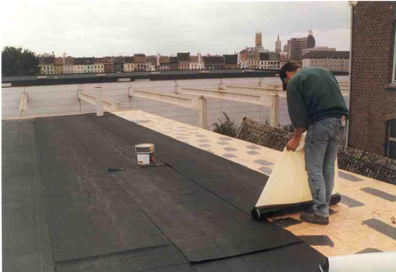
Partieel gekleefd zelfklevend EPDM met zelfklevend bitumenlaag aan de onderzijde
