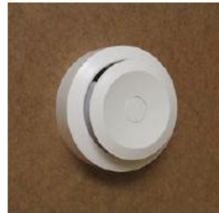
Afb. 49 Ventielen met een weinig of niet-georiënteerde luchtstroom, die geen of slechts een beperkte worp creëren.
