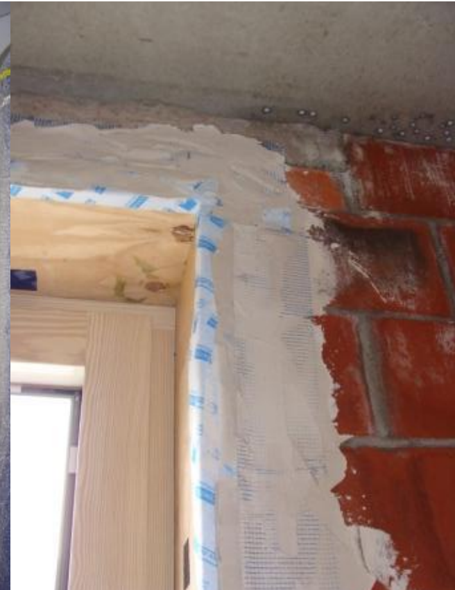
Rond de ramen wordt het netje van de luchtdichting eerst met gips vastgezet
