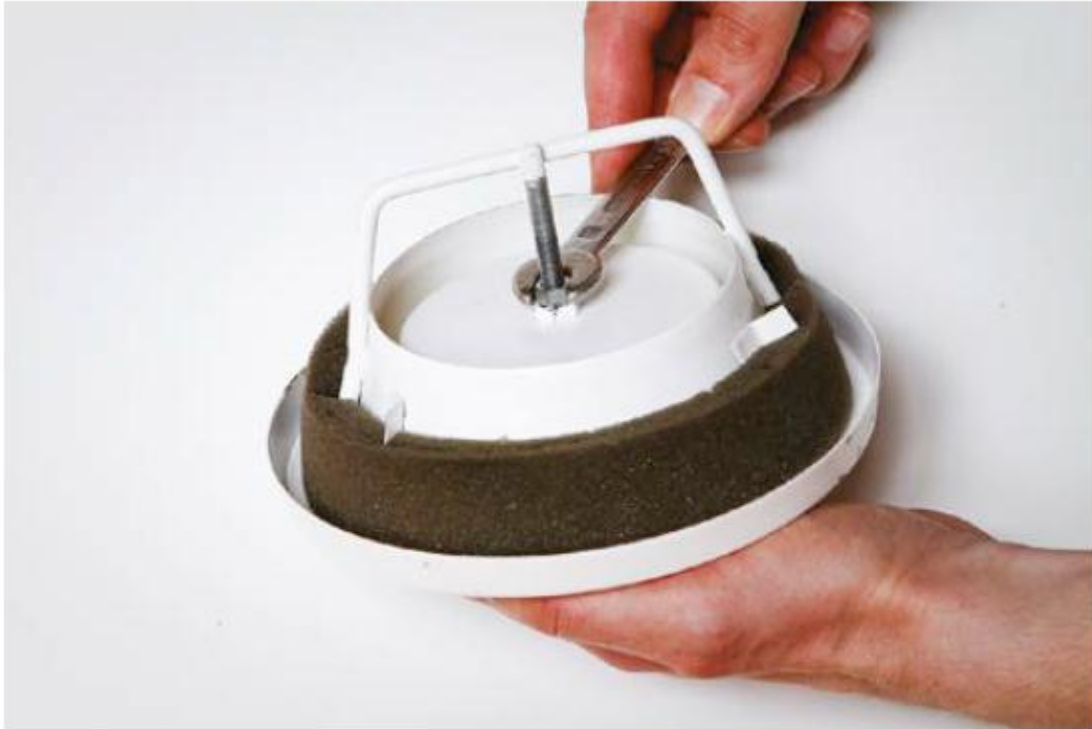
Afb. 91 Geblokkeerd en gemarkeerd ventiel (naam van de ruimte, ontwerpdebiet en afstelpositie).
