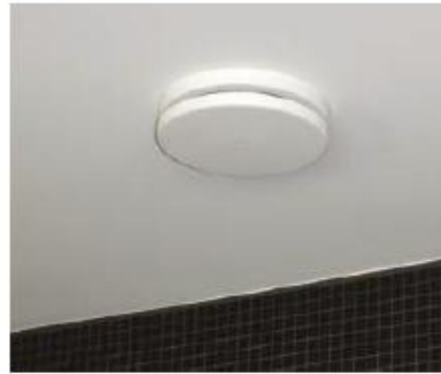
Afb. 46 Ventiel met zijdelingse luchtstroom.
