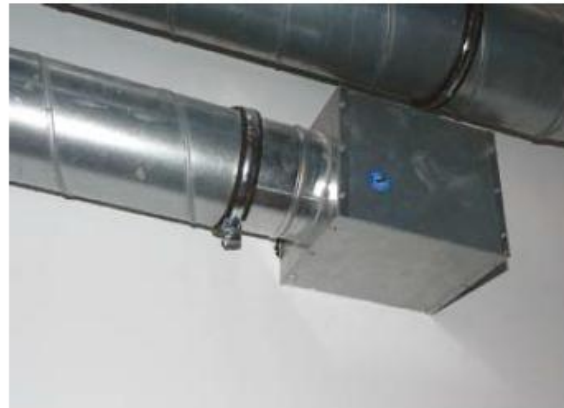
Afb. 44 Plenums die een zekere geluidsdemping (en andere functies: afstelling, meting ...) mogelijk maken.
