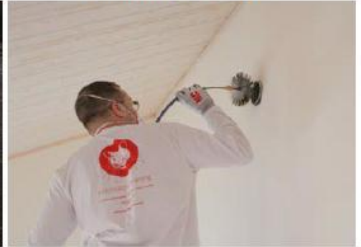
REINIGING VAN EEN KANAAL MET BEHULP VAN EEN ROTERENDE BORSTEL
