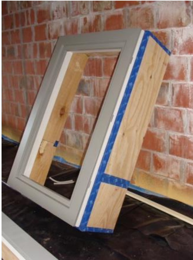
Passief buitenschrijnwerk zit in een luchtdichte multiplex omkasting
