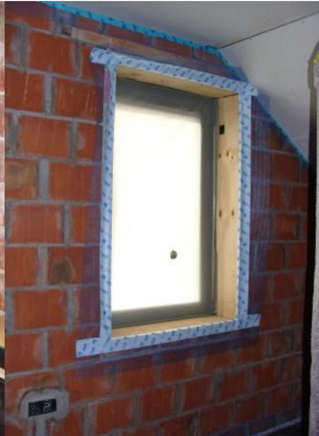
Luchtdichting rond ramen
