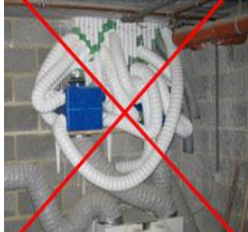
Afb. 1 Kanalennet voor mechanische ventilatie : een voorbeeld van een goede (links) en een extreem slechte (rechts) installatie.
