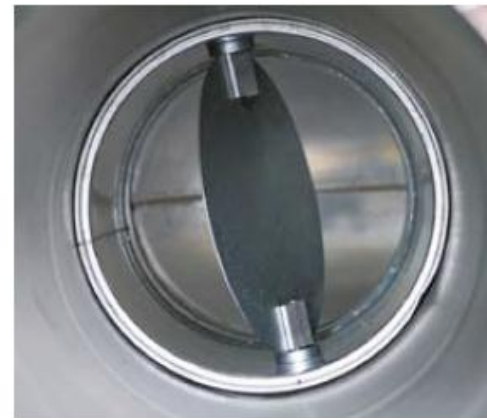
Afb. 73 Voorbeelden van obstakels die de doorgang van de reinigingsborstel verhinderen: afstelklep (links) en geluids- demper met schotten (rechts).
