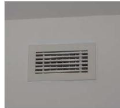
Afb. 49 Ventielen met een weinig of niet-georiënteerde luchtstroom, die geen of slechts een beperkte worp creëren.
