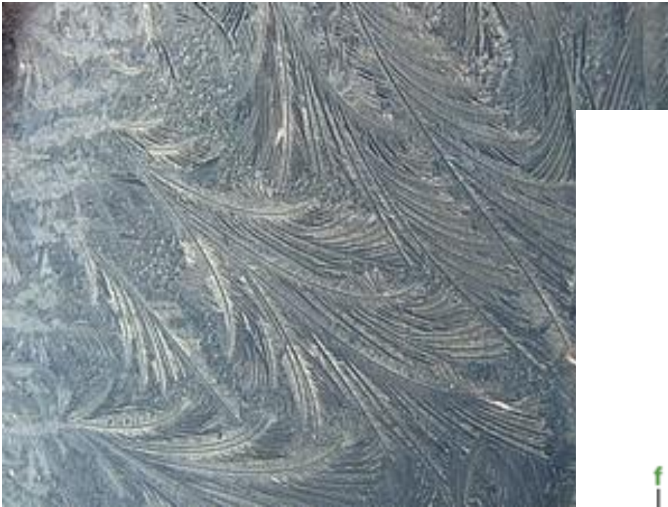
Bevroren condensatie op enkel glas
