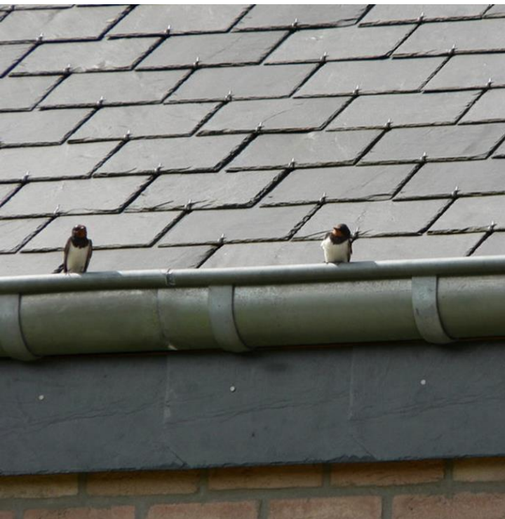
Afb. 3 Afgeknipte bovenhoek en bevochtiging van de geplaatste leien.
