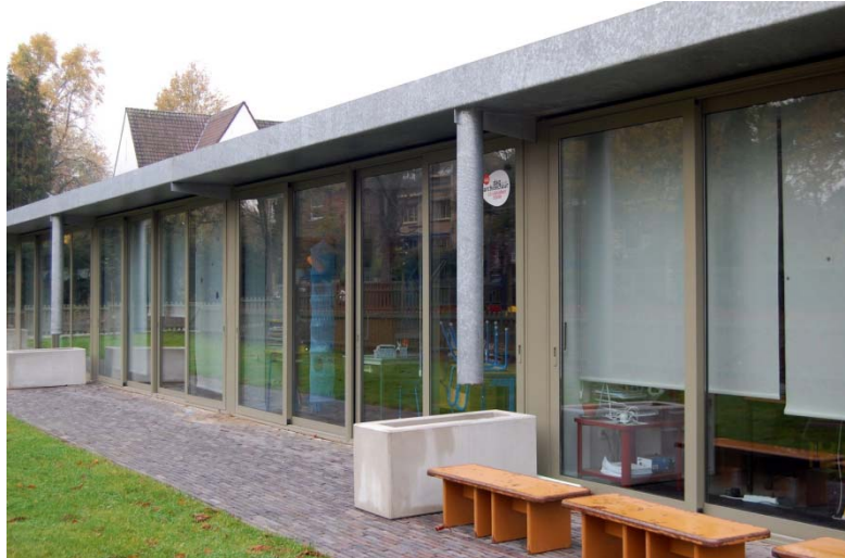
Figuur 8 De gevelisolatie werd voor deze situatie geen meten op 27 dB: eerder nipt dus! (De Klare Bron, Heverlee)
