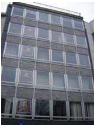
Het pand voor verbouwing
