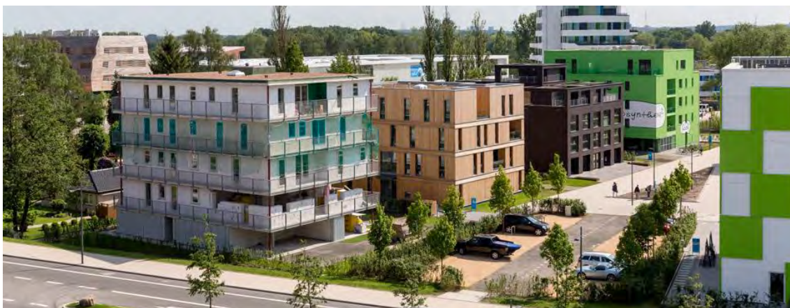
Figuur 3.15: Het appartementsgebouw 'Grundbau und Siedler' werd als één van de geselecteerde projecten in de categorie 'Smart Price Houses' voor gebouwenexpositie IBA Hamburg gebouwd in Hamburg Park 2013 © IBA Hamburg
