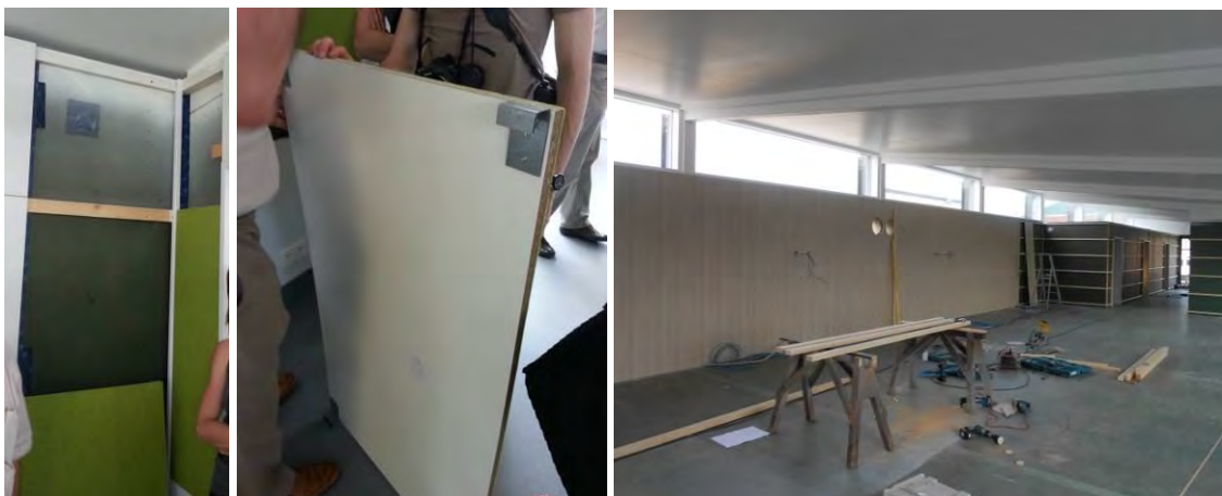
Figuur 3.42: (links) wand in het demogebouw waar een aantal binnenwandpanelen zijn gedemonteerd. (Midden) ophangstelsel/achterzijde van de demonteerbare panelen. (Rechts) voorbeeld van een andere mogelijke binnenwandafwerking. (rechter foto: Hahbo, 2014)
