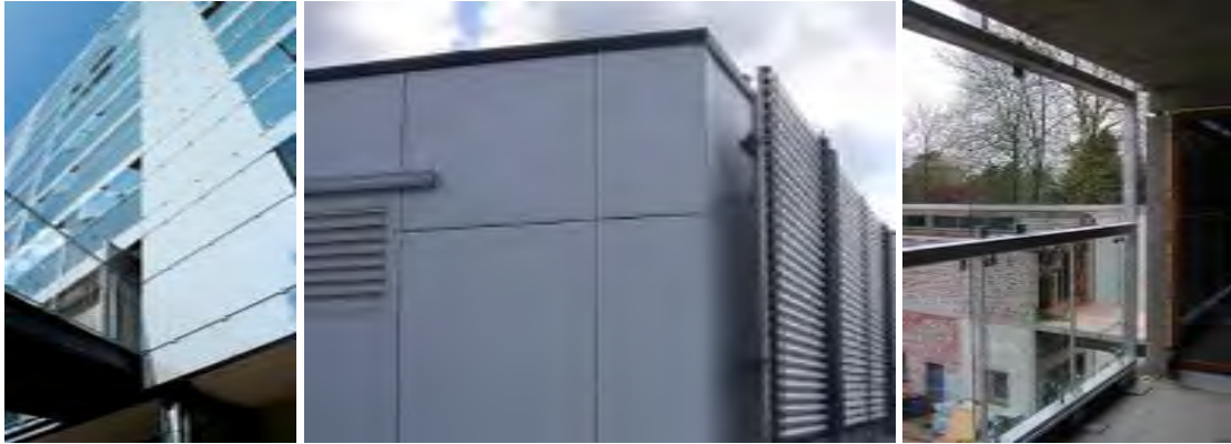
Figuur 3.11: Demonteerbare gebouwonderdelen in Sterrenveld © LEHR
