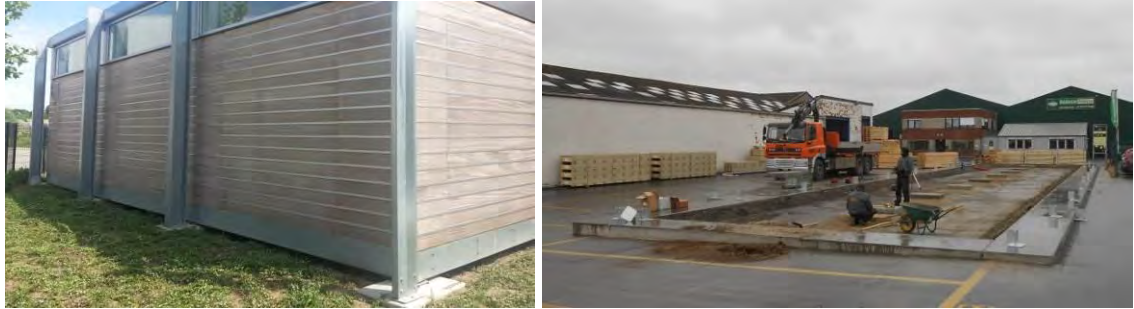
Figuur 3.36: (links) het demogebouw op prefab funderingssokkels en (rechts) gegoten plintbalk in combinatie met een aantal prefab sokkels als fundering voor het in april 2014 opgeleverde kantoorgebouw bestaande uit vier 8x8 modules. (rechts: foto Hahbo, 2014)
