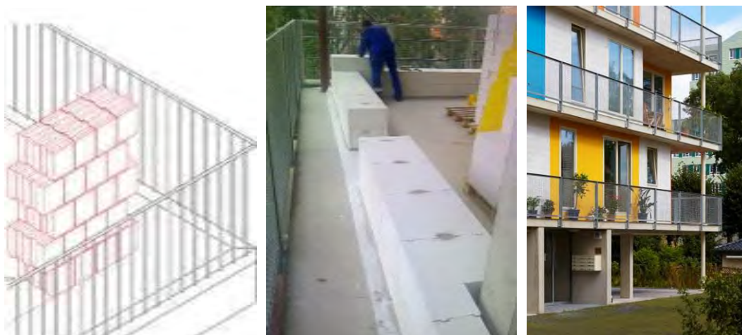
Figuur 3.18: Eenvoudige opbouw van de gebouwschil door middel van geïsoleerde bouwstenen © IBA Hamburg © BeL Sozietät für Architektur
