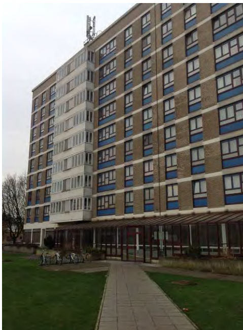
Figuur 5.1: Buitenzicht van de bestaande situatie van de case in Zelzate
