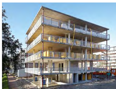
Figuur 3.16: De draagstructuur van 'Grundbau und Siedler' volgens de principes van Maison Dom-ino van Le Corbusier © Le Corbusier © IBA Hamburg
