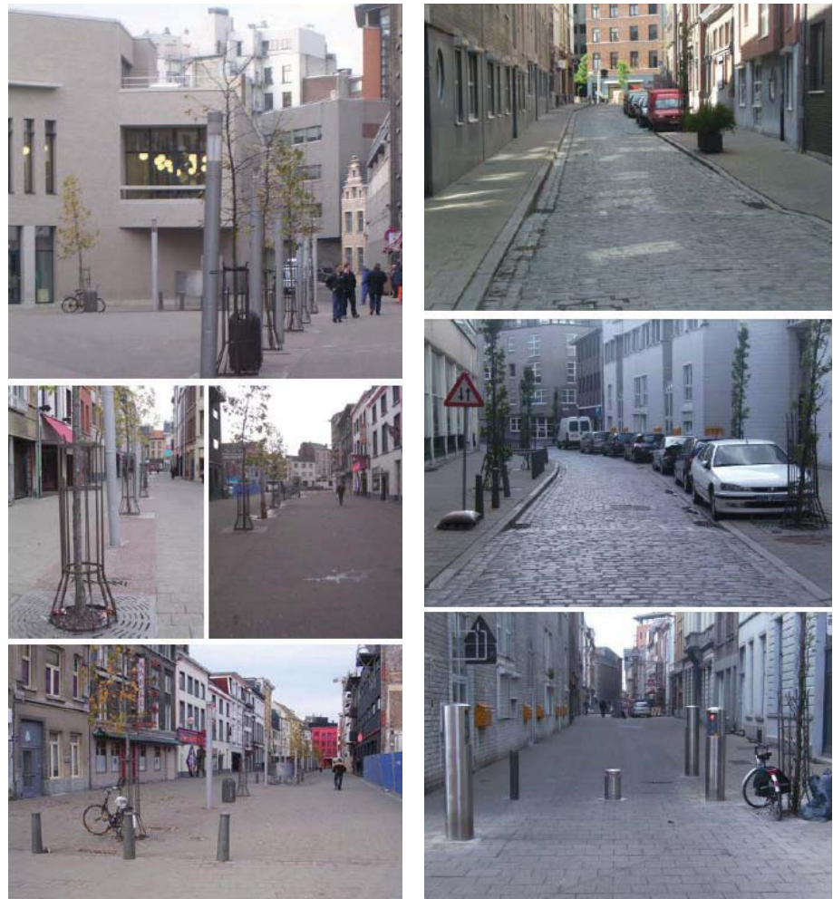
figuur 62: heraanleg openbaar domein in het concentratiegebied (links) en in de straten daarrond (rechts) (bron: (Stad Antwerpen stedelijke woondienst 2007d))
