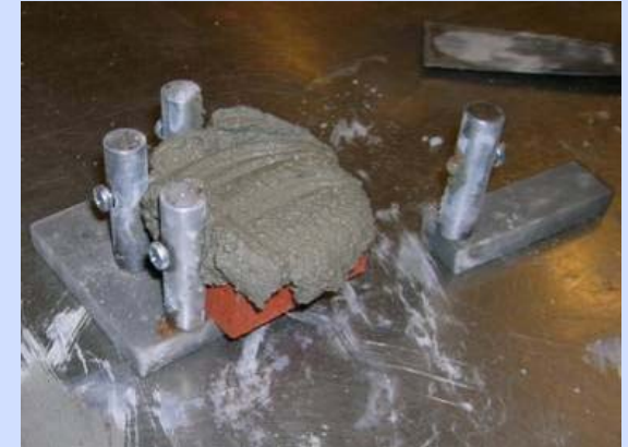
Step 2: hybrid mortar layer
